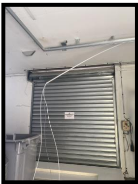
Cable insérer dans le tube puis suspendue
