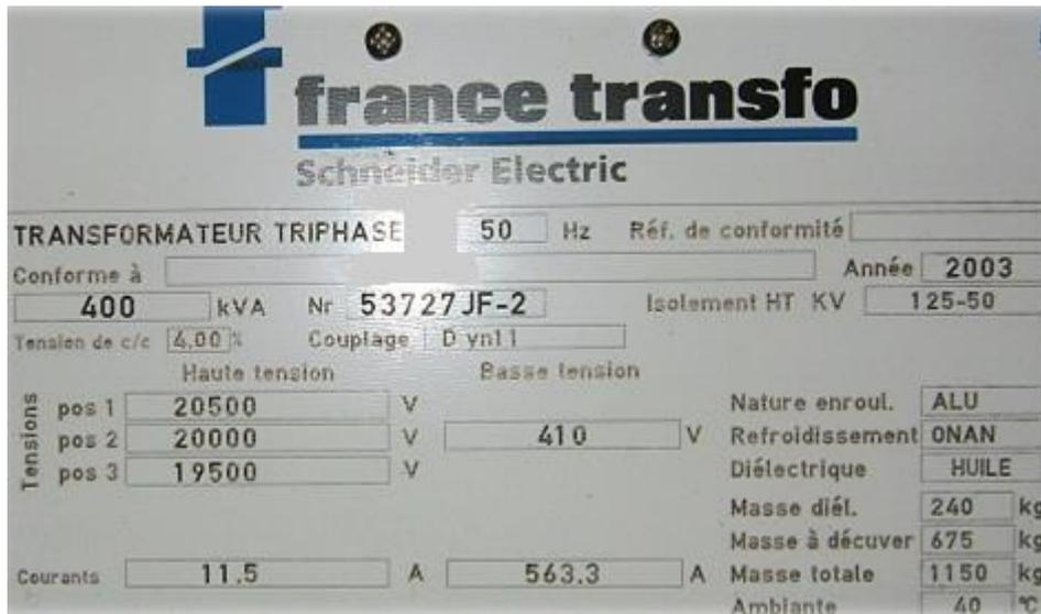
1. Donner les caractéristiques électriques suivantes de ce transformateur : tension secondaire (BT), tension maxi au primaire (HT), puissance apparente, courant nominal au primaire et au secondaire.
