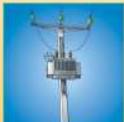
Transformateur moyenne tension/basse tension
