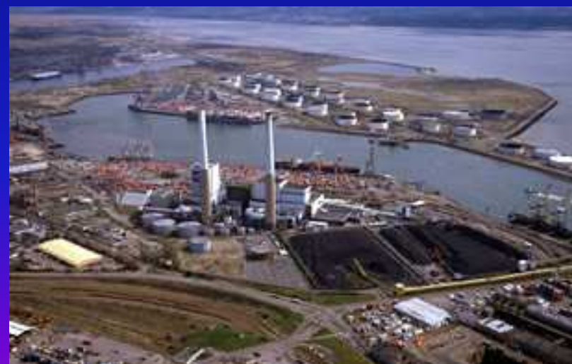
Centrale thermique du Havre : 1,45 GW, 5TWh/an 2 millions de tonnes de charbon
